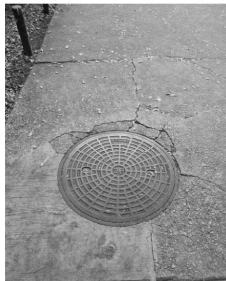
⑬A 5 棟と A 2 棟の間の歩道
