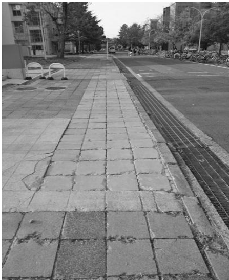
⑭A 5 棟前歩道
