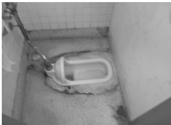
③ A 1 1 棟の 1 階男子トイレ
