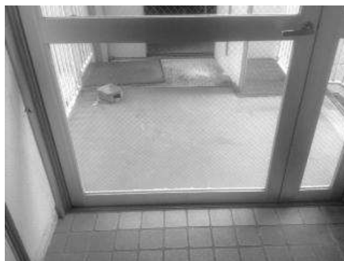
②B13棟-B12棟2階連絡通路(B12棟側)
