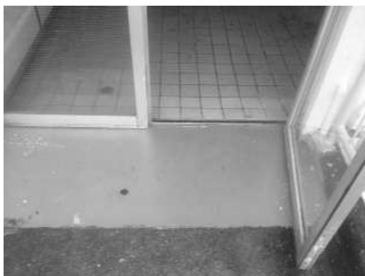
③B12棟2階第一会議室前扉
