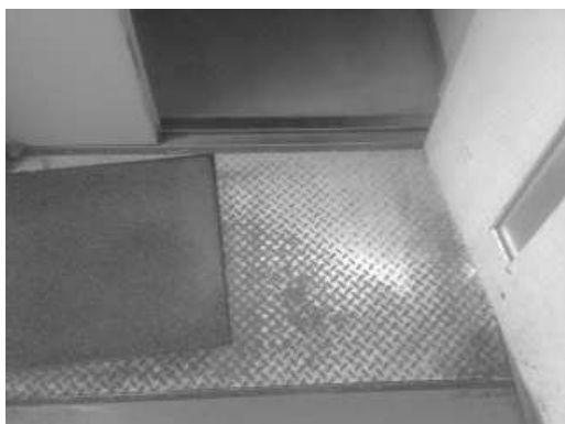
①B13棟-B12棟2階連絡通路(B13棟側)
