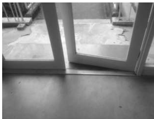
④B12棟2階大集会室前扉
